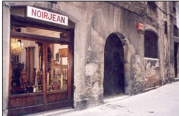
Vista de detall de l'entrada de l'edifici
