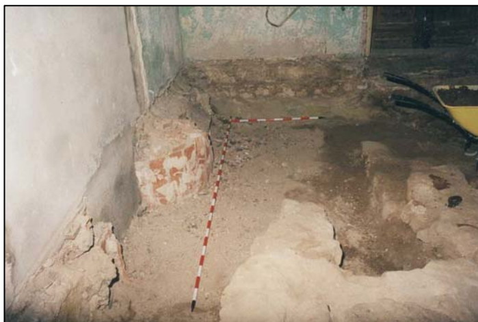
Vista general de l'àrea afectada per la instal·lació de la bomba de gasoil
